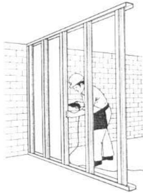
9. ábra Rígips lapok rögzítése
